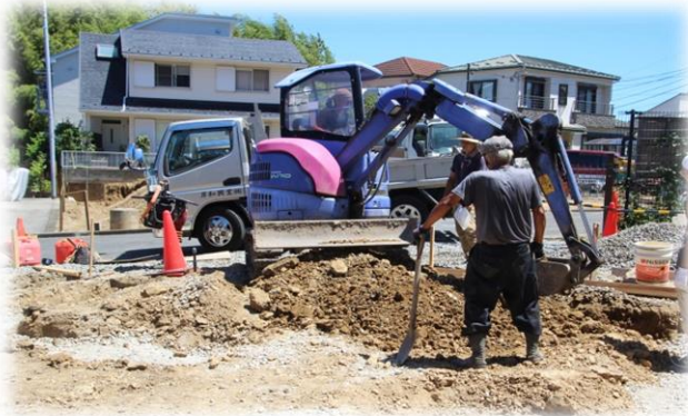
石を据えるために、重機で穴を掘ります
