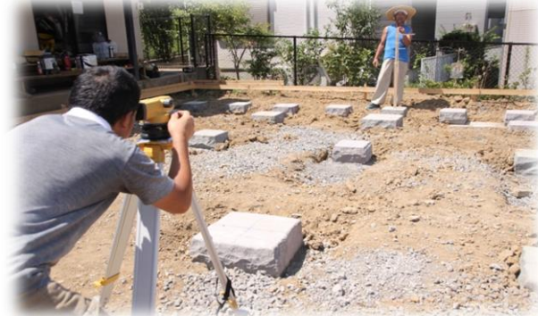
地面と石の高さが場所によって違うので、レベルという測量器を使って、高さを調べます。その後、それぞれの石の上にくる柱を、その高さに合わせて切ります。
