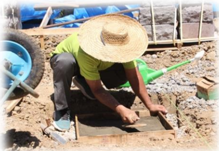
砂とセメントを水を混ぜずに空練りしたものを敷きます(石を安定して置くための工程です)
