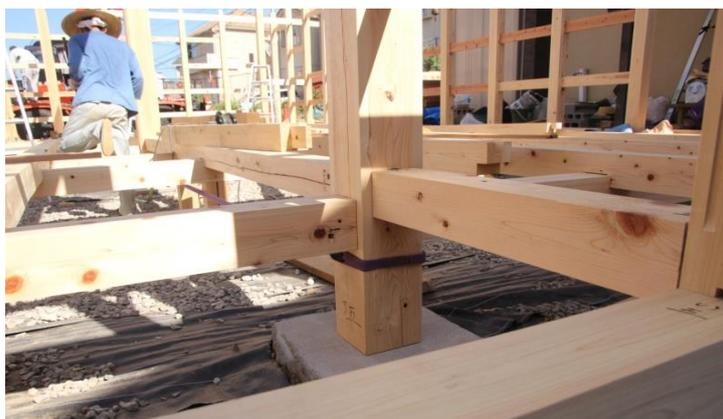
込栓という材料を打って、柱の位置を図面通りの位置に合わせ、固定させていきます。込栓は釘の代わりに使う、木製の栓です。
