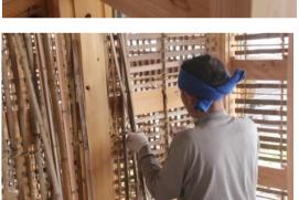
左上:間渡しの竹(女竹:めだけ)を取り付けるための墨付けをします。
